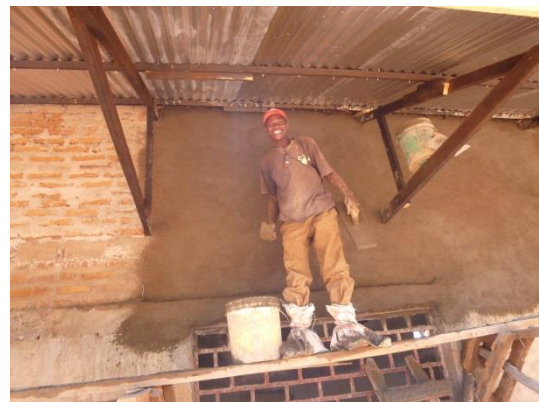
Der Außenputz kommt & „Zementsack Gummistiefel“
