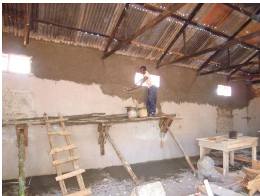
Verputzen der Wände in der Werkstatt
